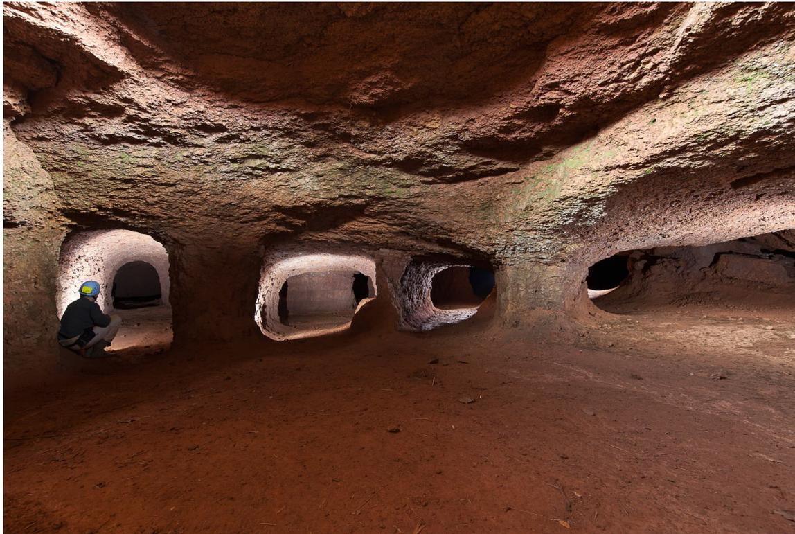
**Fig. 4 : Les galeries d'exploitation filantes A, H, I et J vues depuis l'accès A11. On peut noter différents types de sections. Mine de fer de Gounoudoudji (photo J. & L. Triolet).**
