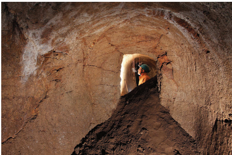
La communication entre les deux chambres du souterrain vue depuis la seconde salle (B) ; la terre en provenance de l'effondrement affectant la première salle (A) encombre le passage (Photo J. & L. Triolet)
